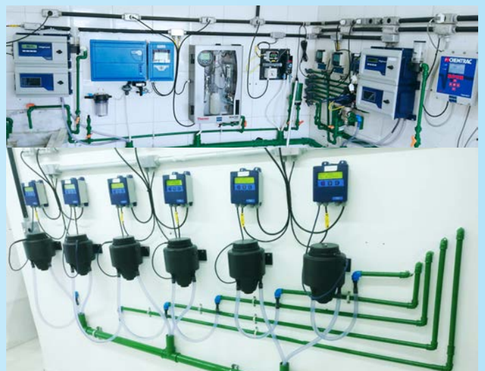
Exemplo Instrumentação analítica em ETAs
